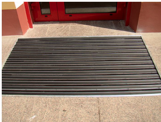
г. Москва, магазин, придверное грязезащитное покрытие
